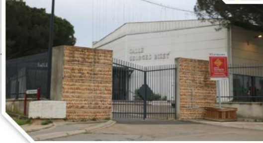
● Mise en accessibilité de la salle Bizet
